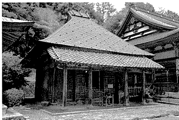
⑦ 千手寺開基堂(旧観音堂) 1棟 亀岡市・千手寺
